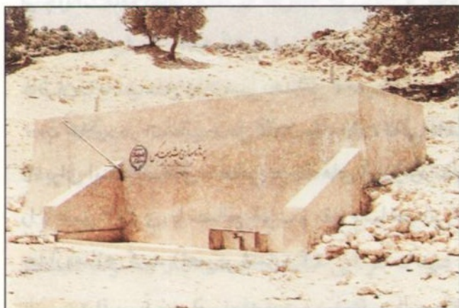
تصویر شماره ۵: پوشاندن مظهر چشمه‌ها، باعث جلوگیری از آلوده شدن آبهای آشامیدنی می‌شود
